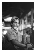
Operário em obra de construção da estação Clinicas do metrô, linha 2 verde, 1990.
